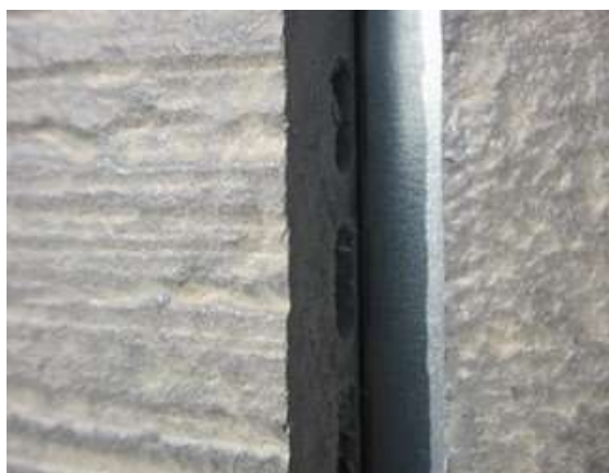
中空穴が露出している場合
