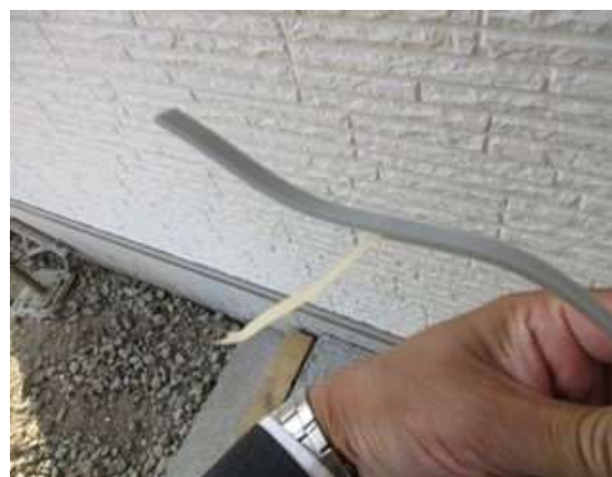
バックアップ材：幅はハット型ジョイナーより小さめ （現調） 厚みを数種類準備し、状況により使い分け
